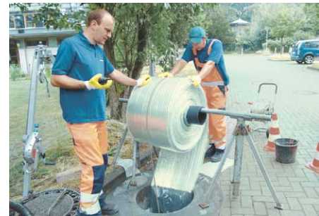
Introduction de la natte d'échange thermique
