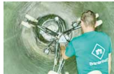
Polymérisation des gaines
