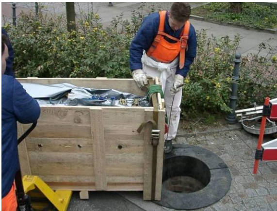
Fig. 7 Edge protection at the shaft
