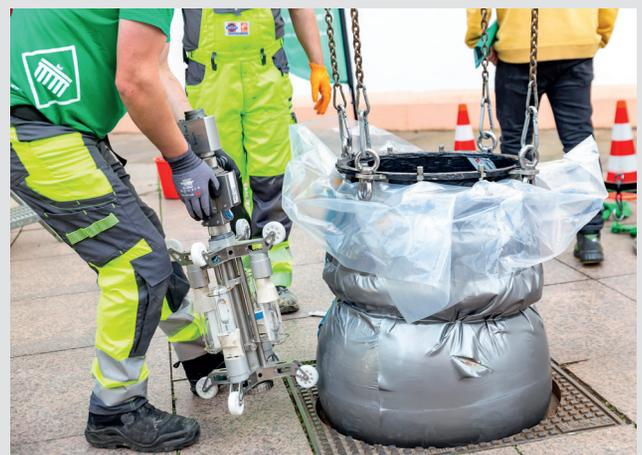
**Bild 1:** Aushärtung eines BB<sup>2.5</sup>VERTICAL im Rahmen einer Demobaustelle in Ettlingen innerhalb der Fußgängerzone
