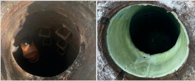
**Bild 2:** Auskleidung eines Schachts mit dem BB<sup>2.5</sup>VERTICAL mit versetztem Konus und Neigung zur Senkrechten (links: vorher, rechts: nach der Aushärtung, vor dem Entfernen der Innenfolie)
